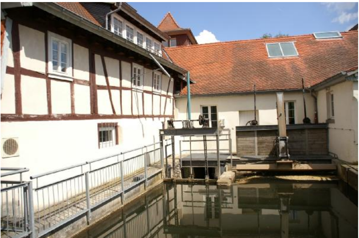
Abbildung 4: Stadtmühle Babenhausen, Zulauf zur Turbine.
