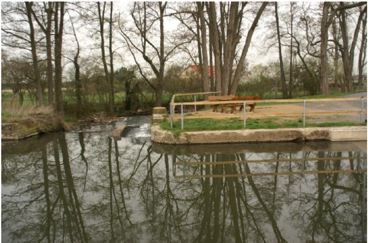
Abbildung 6: Wehranlage bei der Konfurter Mühle.
